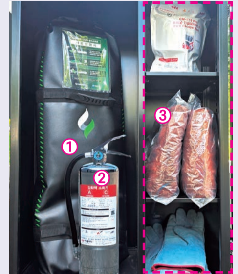
①소화덮개 ②리튬배터리 전용소화기 ③장갑·보호구
