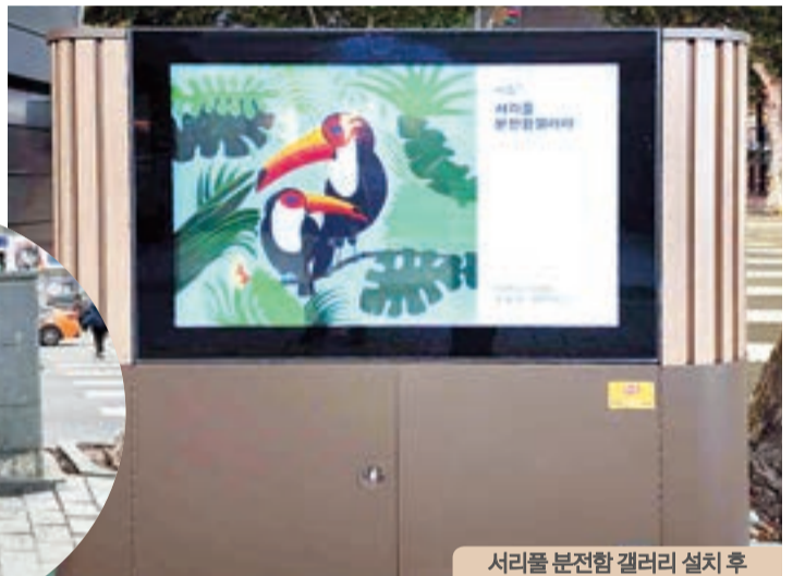
서리풀 분전함 갤러리 설치 후
